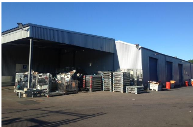
Figur 4. Anläggningen för farligt avfall.
