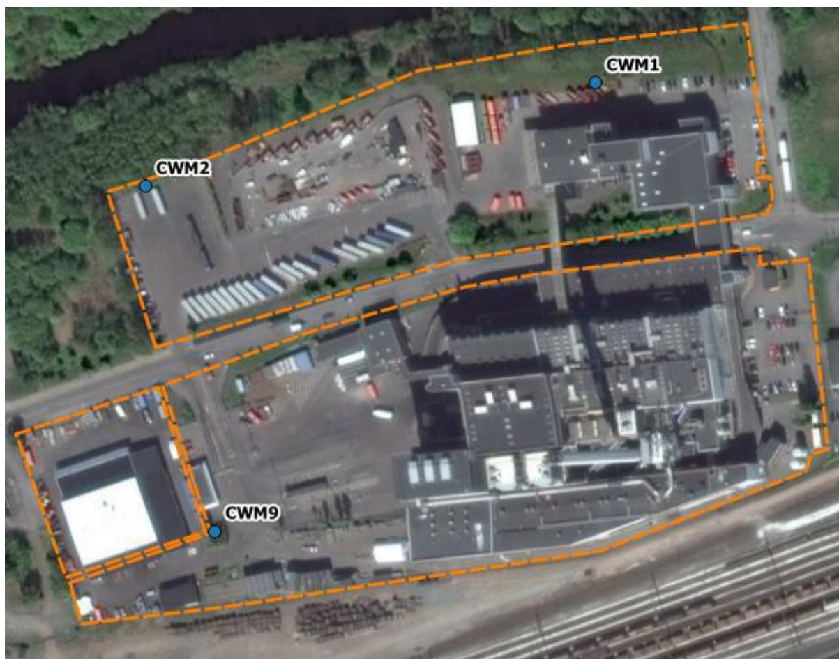
Figur 1. Placering av grundvattenrör.
