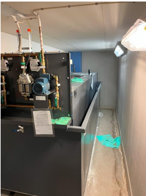
Figur 11. Dieseltank och invallning.
