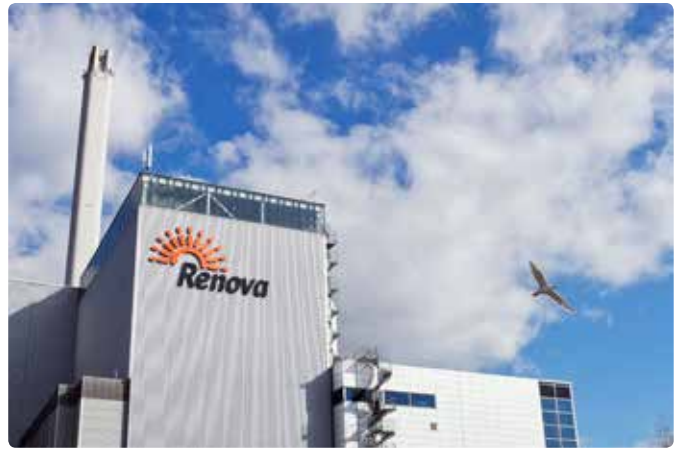
Sävenäs Waste-to-Energy Plant, Gothenburg.
