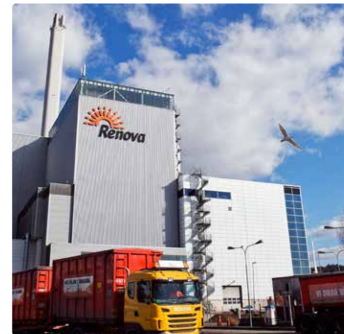
Avfallskraftvärmeverket i Sävenäs, Göteborg.
